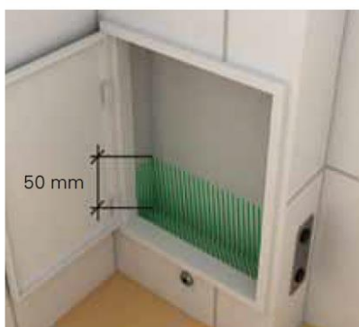
Figur 23 Exempel på installation med tätning från botten upp till 50mm (Branchregler fig. 2.4.1c) Figur 24 Våtzon 1 (Branchregler fig. 2.11.1a).
